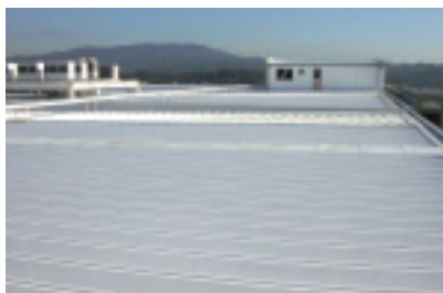
断熱塗装を施した豊田工場
